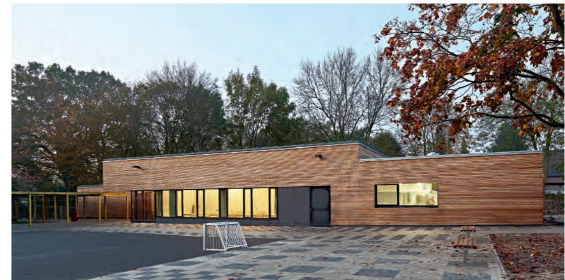
Das erste Schulbau-Projekt für die Schulbau Hamburg: Neubau einer Cafeteria für die Grundschule Burgunderweg in Niendorf (2014). Die Holzfassade passt hervorragend zum ländlichen Umfeld.
