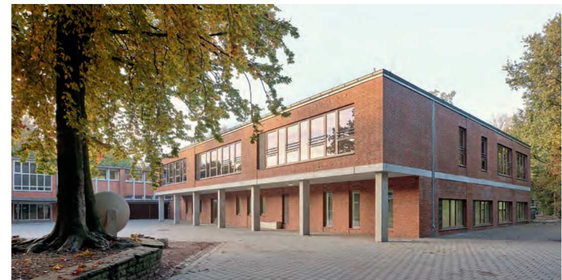
tun-architektur sind Meister darin, die Schulen der 1950er Jahre zu sanieren und zu ergänzen. Hier ein Neubau mit Klassenzimmern und Gymnastikhalle inmitten des denkmalgeschützten Seitz-Ensembles der Schule Mendelssohnstraße.
