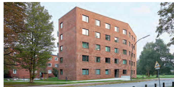
Mehrfamilienhaus mit 19 Wohnungen in Langenhorn, das äußerst geschickt Bezüge aus dem Umfeld der 1950er Jahre aufnimmt.
